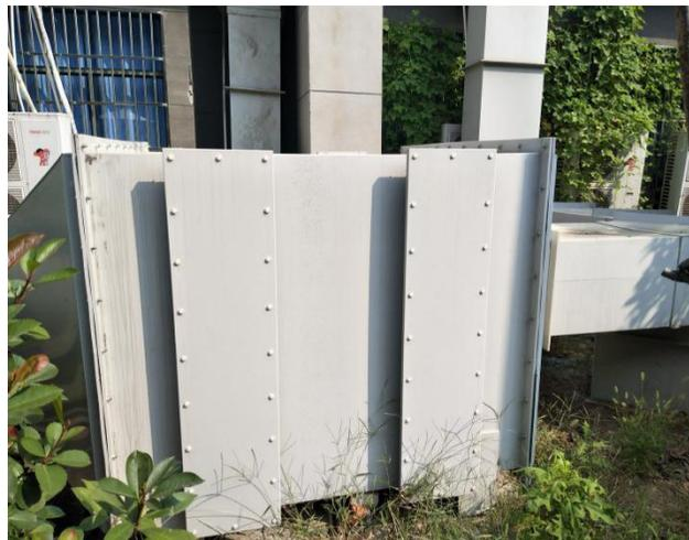
有机废气净化装置
